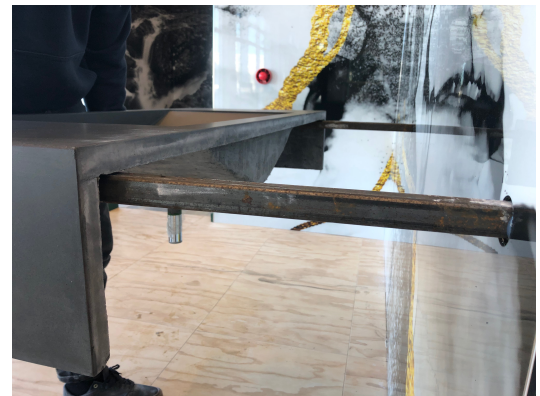
Déposer la vanité sur les braquettes
